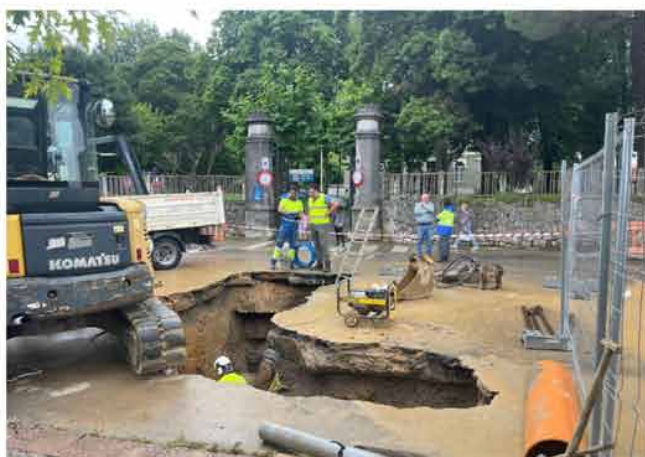
Operarios trabajan en la reparación de la avería de General Dávila, junto a la Finca de Jado. DM
