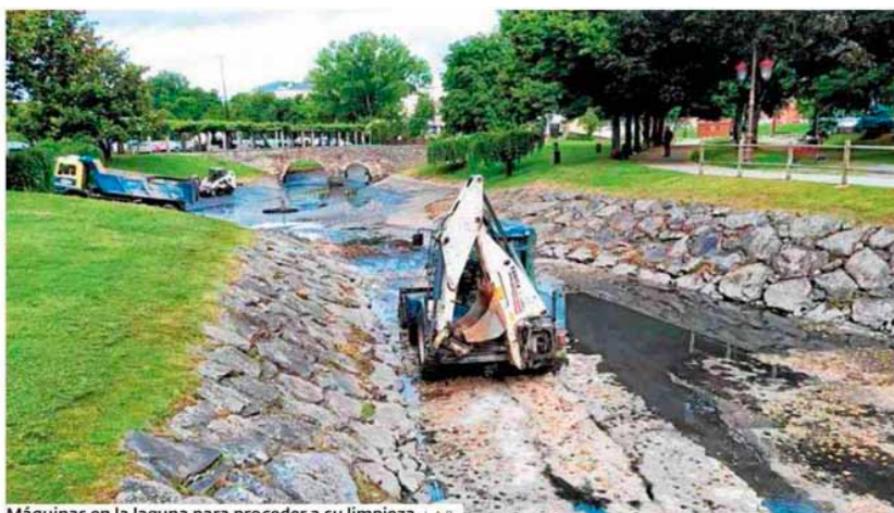
Máquinas en la laguna para proceder a su limpieza. L.A.R.
