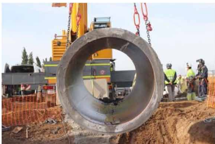
Retirada del tramo de la tubería principal del CAT en Cambrils.
