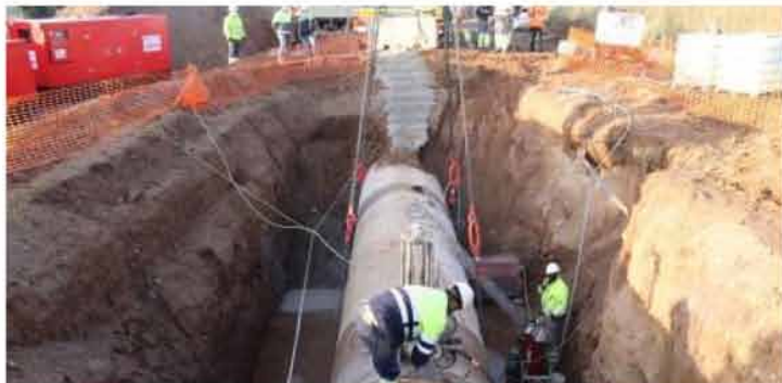
Tubería principal del CAT que se ha sustituido este martes en Cambrils. ACN / Eloi Tost
